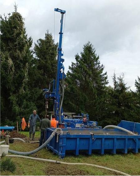
*La construction de la nouvelle station de captage de Vandeuil nécessite que des essais de pompage soient effectués afin de vérifier les débits disponibles.*
