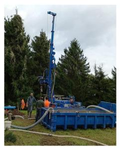
La construction de la nouvelle station de captage de Vandeuil nécessite que des essais de pompage soient effectués afin de vérifier les débits disponibles.
